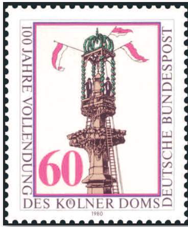
Einsetzen des Schlusssteines in die Südturm-Kreuzblume.
