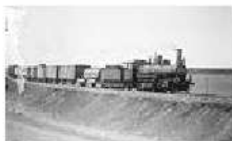
Bahndamm für die Bagdadbahn
