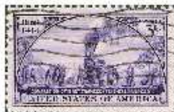
1869 Vollendung der ersten Transkontinentalen Eisenbahnstrecke
